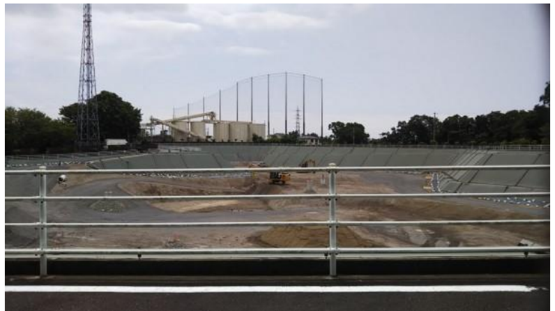
Tsutsumi landfill site
